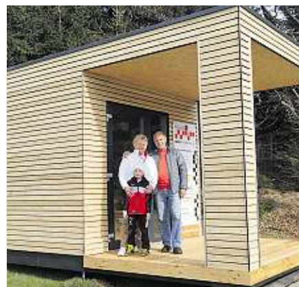
Beim Prototyp - zu besichtigen auf dem Bauhof in Nünchritz - wurden innen OSB-Platten verwendet. Die Verkaufsexemplare haben Holzmehrschichtplatten und eine geschlossene Sanitärzelle. Die Fassade ist aus Lärchenholz. Fotos: Haus 9 - Das Passivhaus
