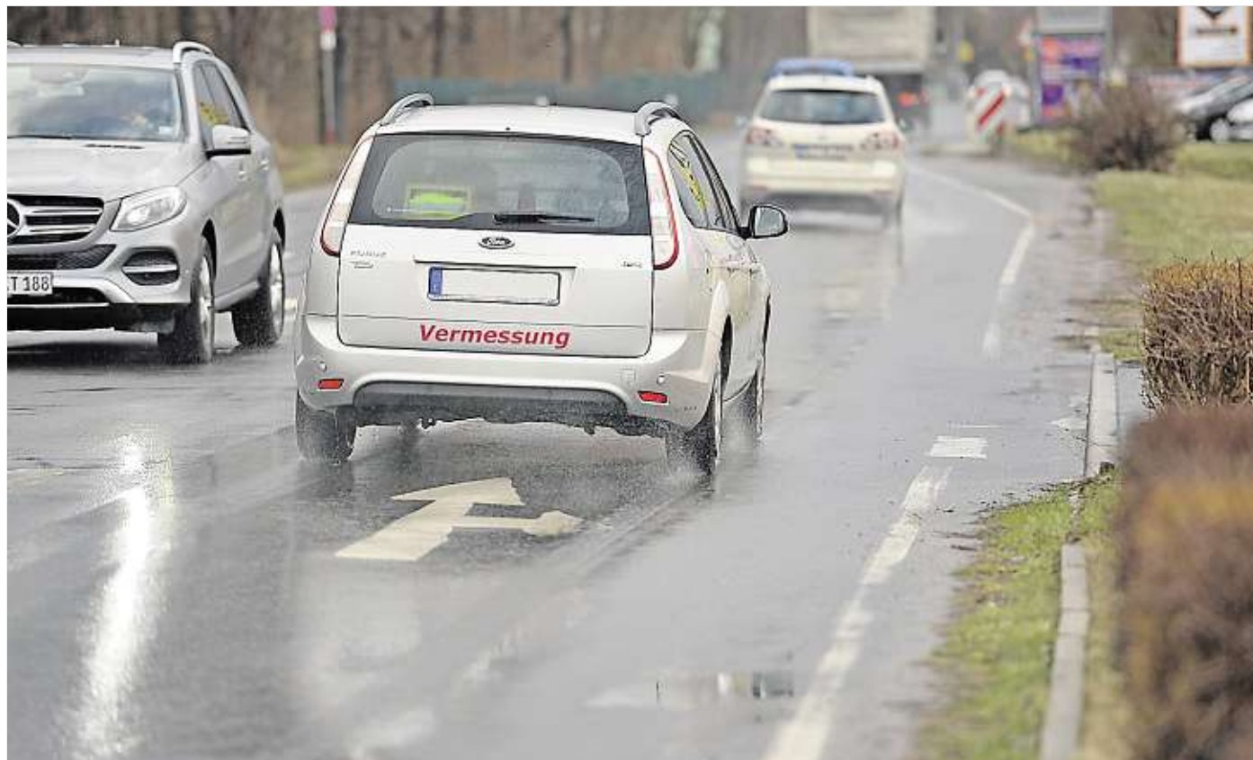
Die S 82 parallel zur Elbe wird ab April bis Ende des Jahres öfters von Bauarbeiten unterbrochen. Der Freistaat lässt zum Beispiel die Asphaltdecke erneuern.
