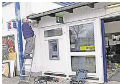
Bau auf, bau auf: Im Auftrag der Firma Card Point GmbH wurde am Donnerstag in Stauchitz ein Geldautomat installiert. Am Freitag soll er in Betrieb gehen. Foto: Sebastian Schultz
